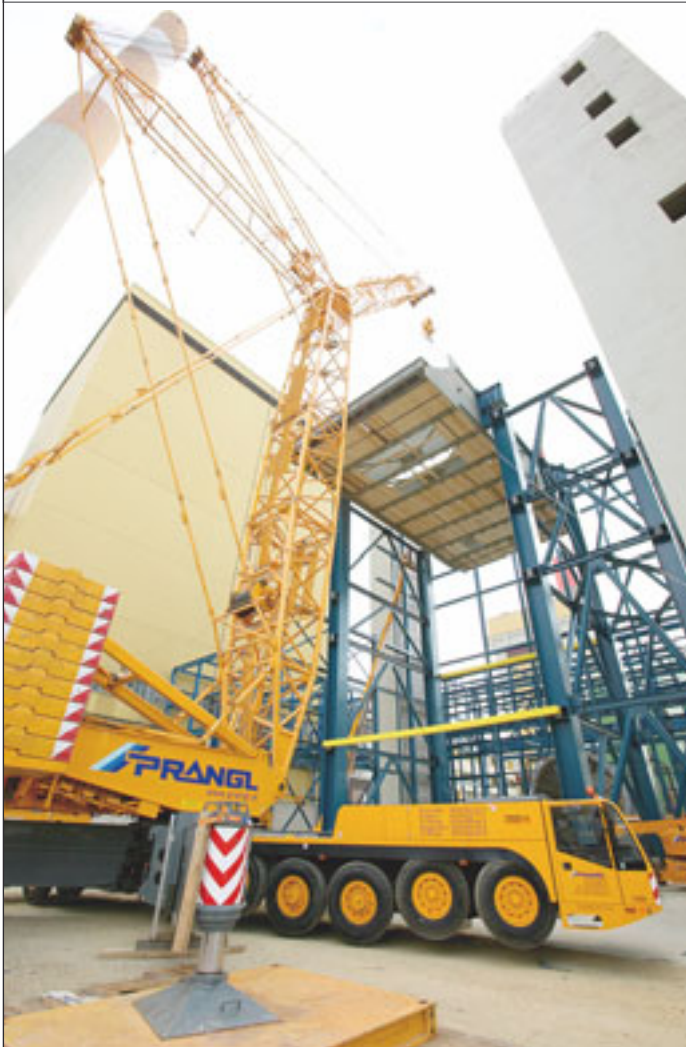
Einer von Felbermayrs LR 1750 beim Einheben eines 170-Tonnen-Teils
