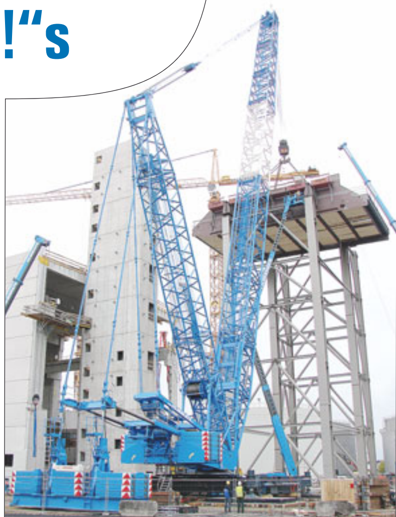
Einer von Felbermayrs LR 1750 beim Einheben eines 170-Tonnen-Teils
