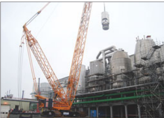
Mit Matten musste der Untergrund erst mal her gerichtet werden
