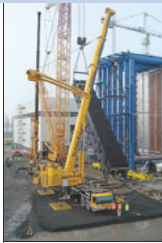
Raupen- und Mobilkran von Schmidbauer in Pont-sur-Sambre
