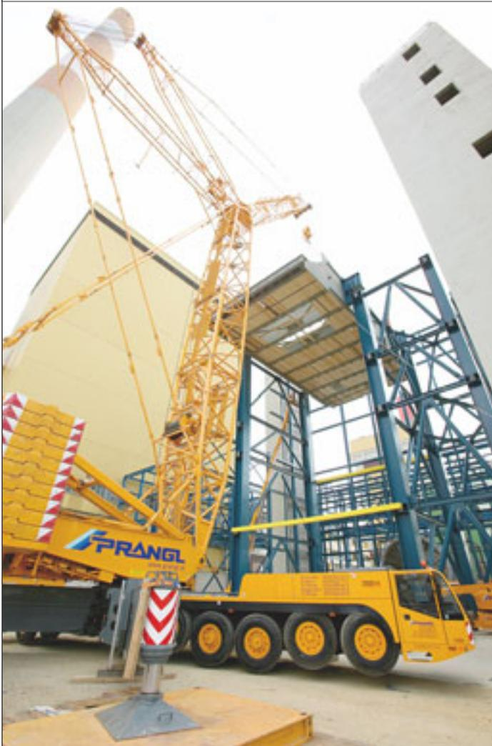
Baukran mit einer Höhe von über 130 Metern innerhalb eines im Bau befindlichen Kühlturms aufzubauen. Die Wiesbauers waren hochzufrieden mit der Performance ihres Neuzugangs: „Auch bei diesem Einsatz und den vorhandenen Örtlichkeiten konnte der GTK1100 alle seine Vorteile zeigen, das heißt kurze Aufbauzeiten und minimale Aufbaufläche bei hoher Hakenhöhe und Traglast“, so das Unternehmen.
