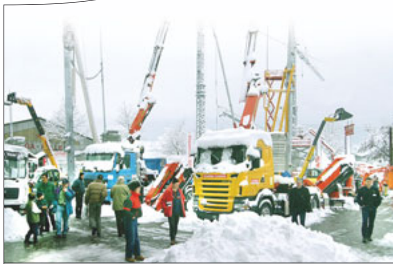
Beim letzten Mal überzog Schnee das Gelände und die Maschinen
