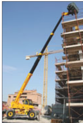
Der Pegasus 40.25 von Dieci auf der Baustelle
