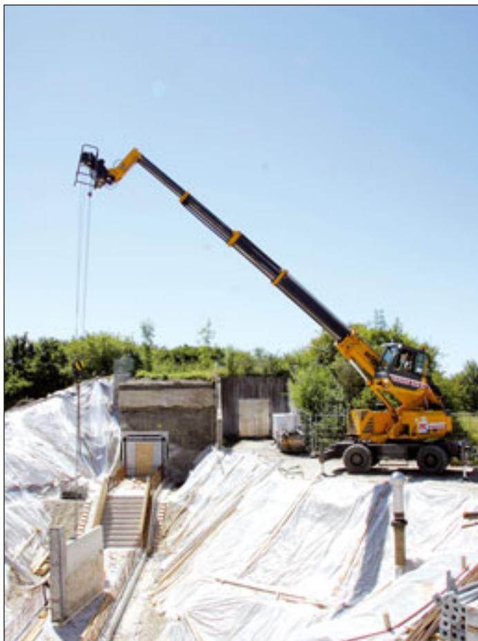
Sennebogens 608 Multicrane im Einsatz bei Kassecker: Die Franz Kassecker GmbH aus Waldsassen baut zur Zeit am Zuleitungsbauewerk Deisenhofen in der Gemeinde Oberhaching. Zwischen dem Fallschacht Gleißental und dem Gleißentalschacht wird dabei ein unterirdischer Verbindungsgang erstellt. Hier ist der 608 Multicrane im Einsatz, zum Teil unter sehr beengten Platzverhältnissen. Ausgerüstet mit Winde erledigt der 608 in erster Linie Schalungs- und Beto-
