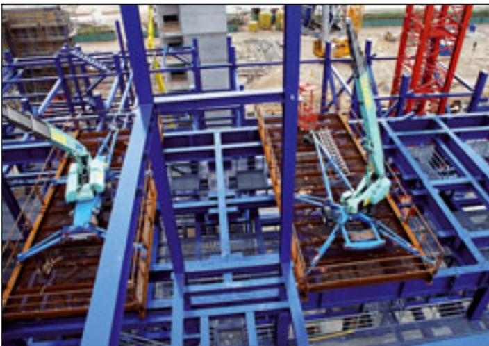
Beim Neubau einer 180 Millionen Euro teuren Müllverbrennungsanlage in Emlichheim wurden Arbeitsbühnen von Zoom spektakulär zum Einsatz gebracht. Um den engen Zeitplan – Fertigstellung bis Ende 2007 – einhalten zu können, entschied man sich, den Höhenzugang durch flexibel einsetzbare Anhängerarbeitsbühnen zu gewährleisten. Für die Platzierung der Bühnen innerhalb des Stahlbaus wurden zwei Plateaus mit einer
