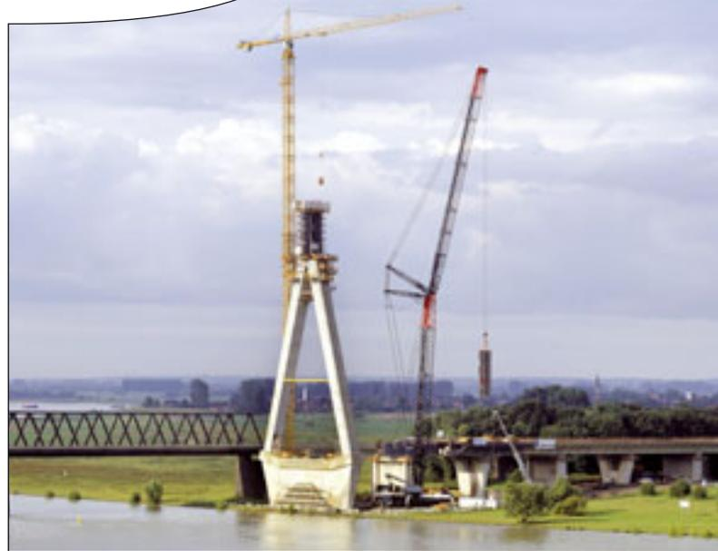
schwere Stahlblöcke darauf. Damit wuchs der Pylon um weitere 45 Meter. Bei diesem Vorgang funkten die Stahlbauer von der Spitze des Pylons Anweisungen zur zentimetergenauen Positionierung der schweren Stahlkolosse, bis diese präzise ihren vorgesehenen Platz eingenommen hatten und verschweißt werden konnten. Die Stahlblöcke dienen zur Aufnahme von insgesamt 72 Brückenseilen mit einem
