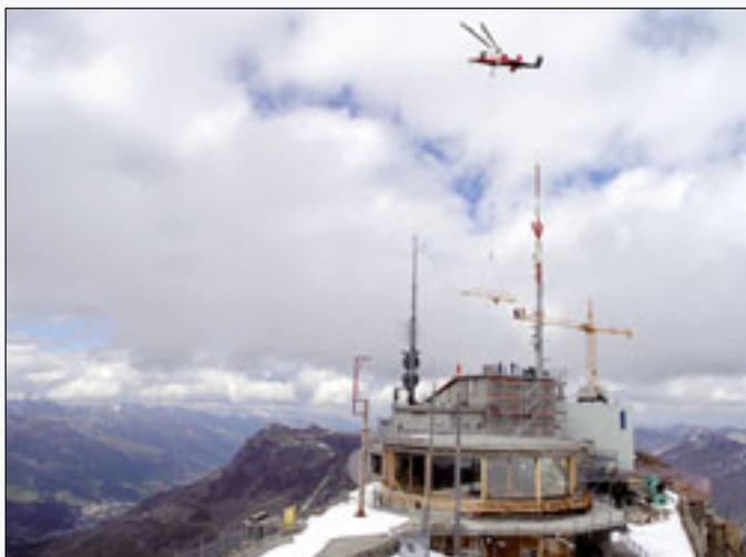
Dank der präzisen Logistikplanung beider Teams und des perfekten Fluges konnte die komplette Montage nach rund vier Stunden abgeschlossen werden. Für die Zubringung aller Einzelteile, inklusive Ballast und Gegengewichten, waren insgesamt 28 Flüge erforderlich. Fünf Helikopterflüge mussten von der Talstation geflogen werden, da die großen Einzelteile nicht mit der Bahn zur Mittelstation transportiert werden konnten.
