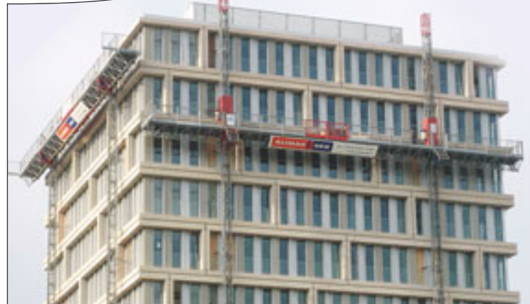
Vier HEK MSM-Mastkletterbühnen mit je 28 Meter Länge umsäumen den Neubau
