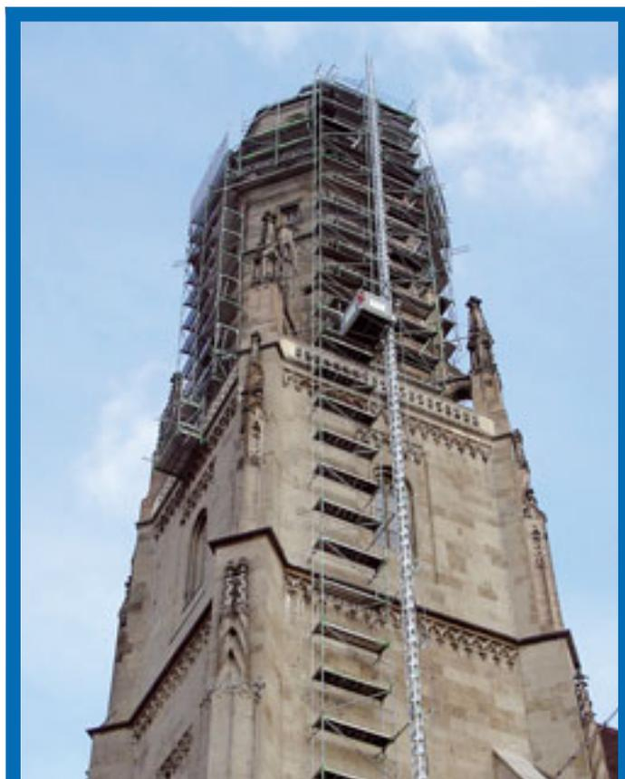
Geda im kirchlichen Einsatz: Um neue Brüstungsteile und anderes Baumaterial am teilweise maroden Turm Daniel in Nördlingen sicher nach oben zu transportieren, wurde über die Gerüstbaufirma Söll aus dem Landkreis Augsburg eine Geda Transporthöhle 500 Z/ZP für Personen und Material angemietet. Die Firma konnte mit Hilfe des standardmäßig eingebauten Montagestegs den Aufzug am Turm montieren.
