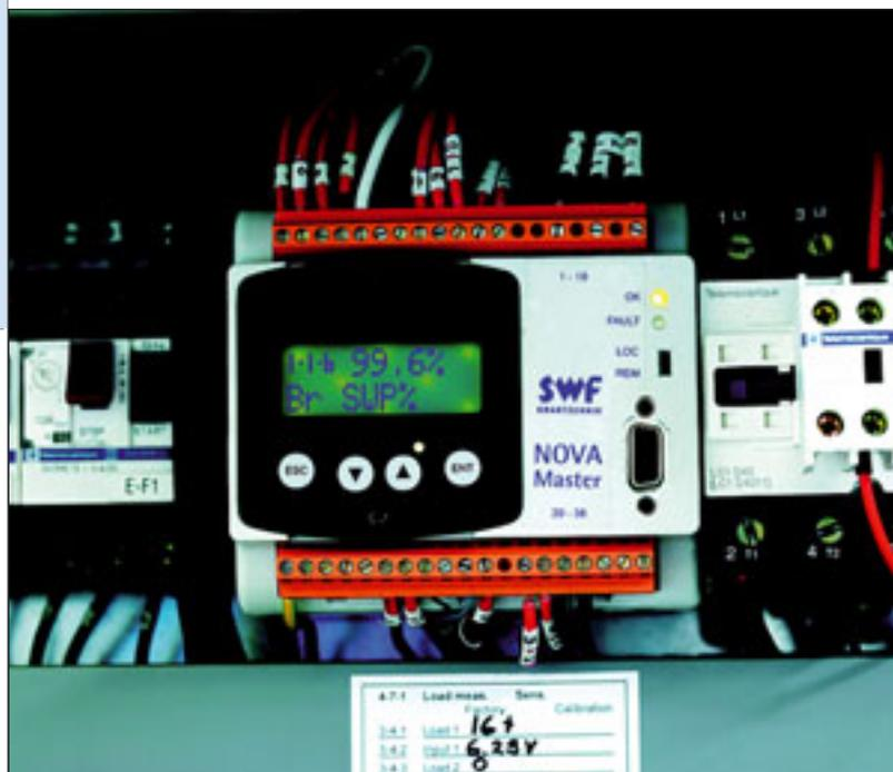
Die elektronische Hubwerküberwachungseinheit „NovaMaster“ von SWF Krantechnik soll ein Höchstmaß an Sicherheit garantieren und zugleich Budget und Hebezeug schonen. Die Einheit kann für die Elektroseilzüge „Nova“ des Mannheimer Hebezeugspezialisten eingesetzt
