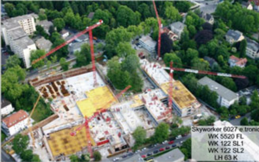
Neubau Deutscher Wetterdienst - Offenbach/Main 2006
