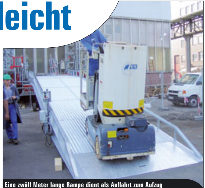
Eine zwölf Meter lange Rampe dient als Auffahrt zum Aufzug
