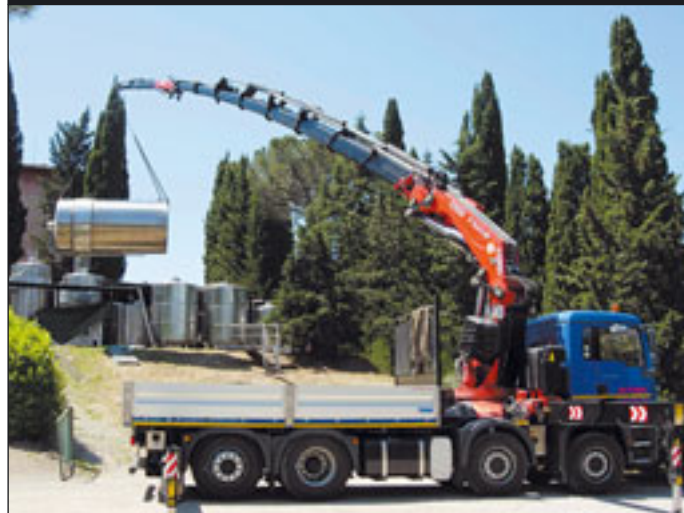
Der Fassi F1100XP im Einsatz
