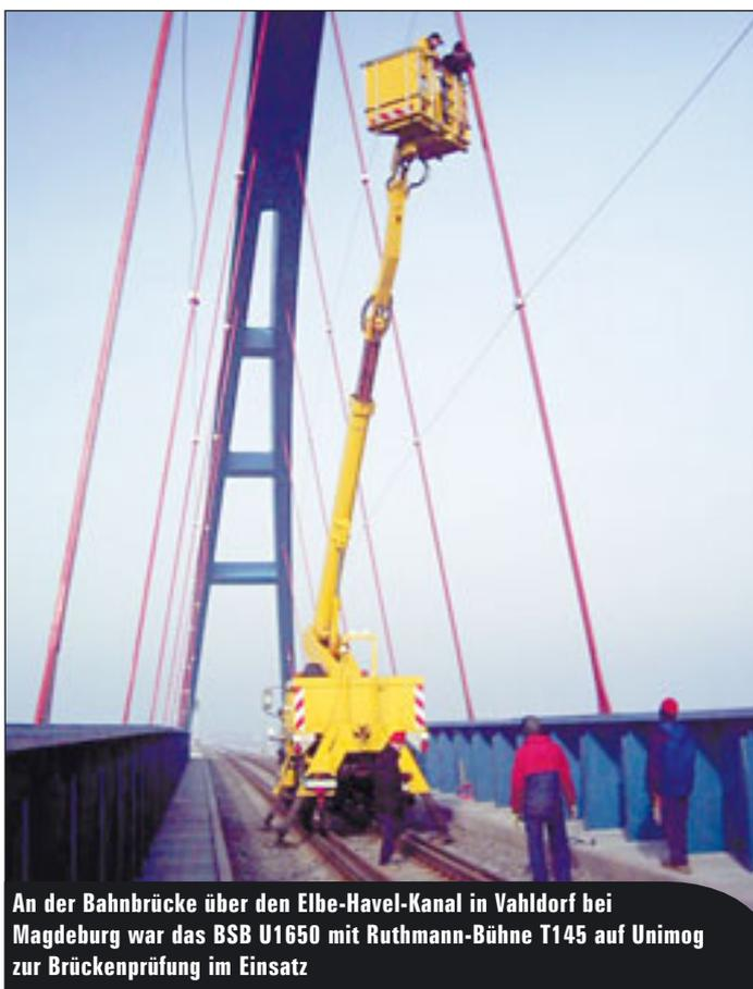
An der Bahnbrücke über den Elbe-Havel-Kanal in Vahldorf bei Magdeburg war das BSB U1650 mit Ruthmann-Bühne T145 auf Unimog zur Brückenprüfung im Einsatz
