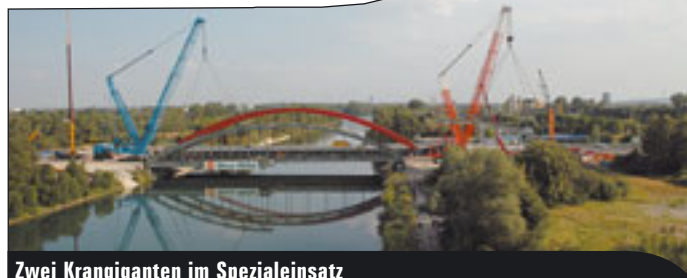
Zwei Krangiganten im Spezialeinsatz
