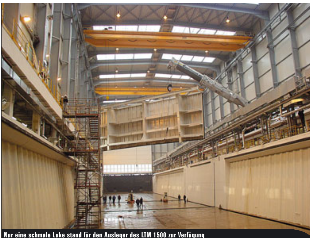
Gedreht und fertig zum Einbau: Schleusentor für Montagehalle
