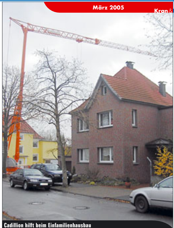
Cadillion hilft beim Einfamilienhausbau
