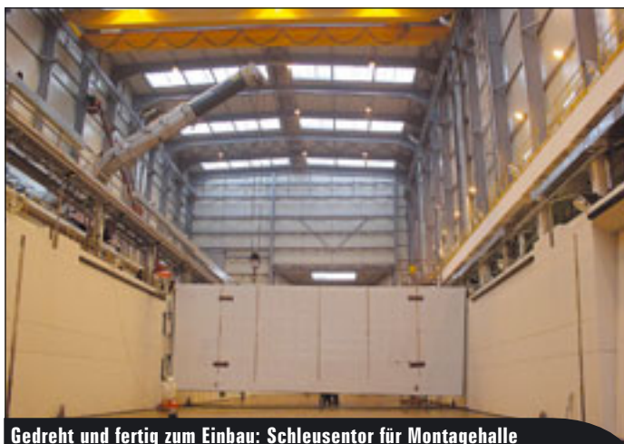
Nach der Anlieferung wird das Tor angehoben
