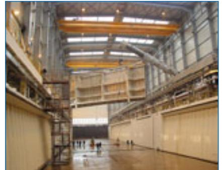
Beim Einheben eines 55 Tonnen wiegenden Schleusentores für eine Werft in Rendsburg arbeiteten ein LTM 1500 und ein Hallen- Brückenkran perfekt zusammen.
