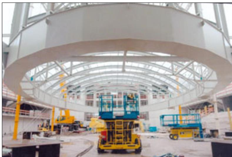
einer Hebebühne montiert hochgehoben und dort verankert. Das Ganze wurde auf 13 Meter Höhe unter die Kuppel
