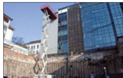
ließenden Erweiterungsbau abgetragen werden. Für die geplante Projektlaufzeit von nur drei Tagen kam eine Liftlux-Schere mit einer Arbeitshöhe von 22,5 Metern zum Einsatz.
