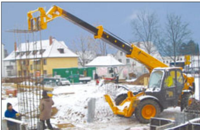
Bei einem Neubau eines Gebäude mit 9000 Kubikmetern umbautem Raum sowie eine 5000 Quadratmeter große Parkfläche für 160 Stellplätze, setzt das ausführende Unternehmen Re-Bau auf einen JCB 535-125 Teleskopklader. Das Gerät mit 3,5 Tonnen Hubkraft und 12,5 Metern Hubhöhe kommt anstelle eines Turmdrehkrans zum Einsatz. Re-Bau hat sich nach intensiver Kostenanalyse bei Bauten mit einer Außenwandhöhe von vier Metern gegen den Einsatz von Turmdrehkränen ausgesprochen.
