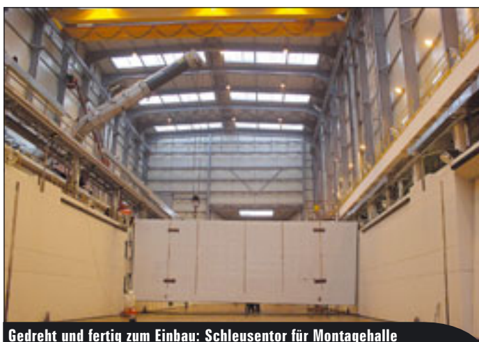
Nach der Anlieferung wird das Tor angehoben
