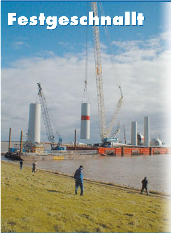
Für die Montage der ersten „Near-Shore-Windkraftanlage“ bei Emden wurde ein Terex-Demag CC 8800 von Sarens auf einem 100 Meter langem schwimmenden Ponton „festgezurt“. Bei dem Einsatz wurden die einzelnen Teile einer Enercon-Windkraftanlage E 112 mit einer Nabenhöhe von 108 Meter montiert. Für diesen Job wurde der CC 8800 mit 138 Meter Ausleger und Superlift-Einrichtung ausgerüstet.
