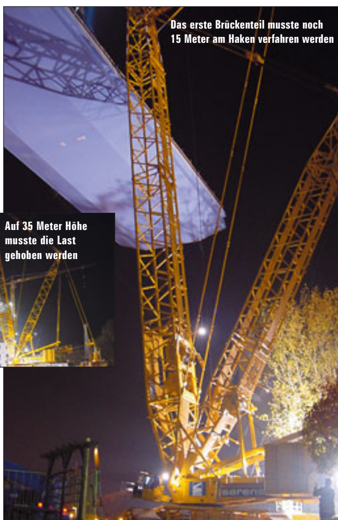
Von den Scherlast-Modulen hat die LR 1750 das 470 Tonnen schwere Brückenteil aufgenommen
