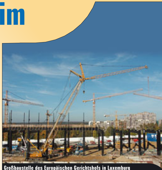
Großbaustelle des Europäischen Gerichtshofs in Luxemburg
