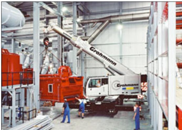
Millimeterarbeit war gefragt, als im Hallenneubau einer Berliner Recycling-Anlage ein sechs Meter langer und drei Meter breiter Windsichter installiert werden musste. Die Maschine, die zur Trennung von Holz, Metall und Papier eingesetzt wird, sollte mit einem Mobilkran zwischen bereits installierten Anlagenteilen vom Tieflader genommen und dann um 90 Grad versetzt in eine Gasse bis an deren
