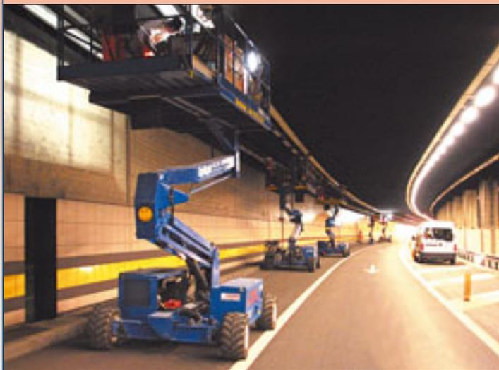
Im 16 Kilometer langen Gotthardtunnel sind im Herbst Wartungsarbeiten durchgeführt worden. Rund 120 Arbeiter haben hierzu zwölf Wochen lang ausschließlich auf UpRight Speed Level Maschinen die Beleuchtung und Einrich-
