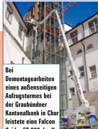
Bei Demontagarbeiten eines außenseitigen Aufzugsturmes bei der Graubündner Kantonalbank in Chur leistete eine Falcon Spider FS 290 der Up AG gute Dienste.
