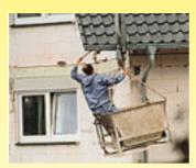
IPAF betont, dass die Halteleinen kurz getragen werden sollten – im Sturzrückhaltemodus – um so zu verhindern, dass der Bediener erst gar nicht aus dem Korb fällt. Eine länger eingestellte Halteleine bietet zwar noch immer Schutz, doch das Verletzungsrisiko ist aus verschiedenen Gründen erheblich. Zu beachten ist, dass die Hersteller von Teleskoparbeitsbühnen das tragen von Sicherheitsgurten auf ihren Geräten empfehlen oder sehr häufig sogar vorschreiben!
