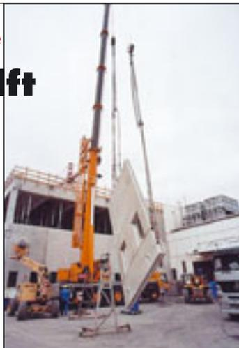
maximalen Länge von 60 Metern und dabei zehn Tonnen Traglast mit Erweiterungsmöglichkeiten sowie die Ausführung als „Maxi-Taxi“ gaben den Ausschlag, ihn hier als „Baumaschine“ einzusetzen.
