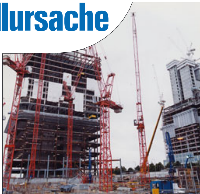
Die Großbaustelle Canada Square, wo sich im Mai 2000 der tödliche Unfall ereignete
