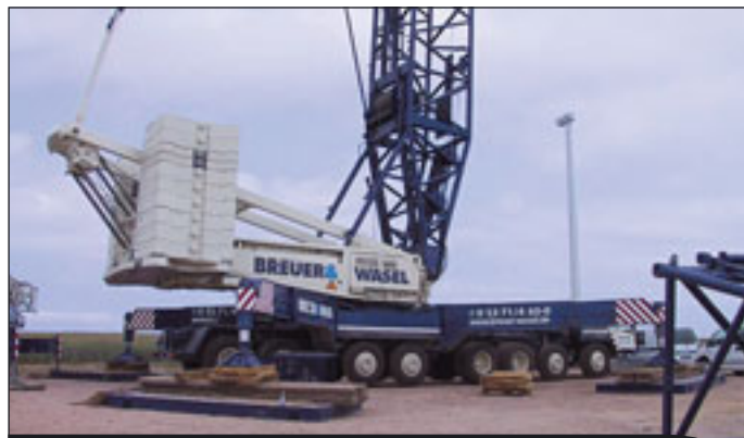
Große Gittermastkrane wie von Breuer & Wasel sind beim Bau von Windkraftanlagen notwendig
