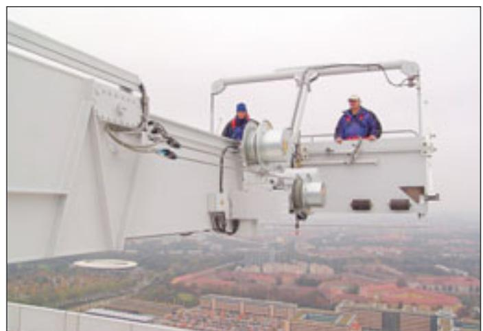
Am 146 Meter hohen Uptown Tower München wird für die Fassadenbearbeitung und -reinigung ein Geda Fassadenaufzug Typ L01 eingesetzt. Die 22 Tonnen schwere Befahranlage ist mit einer separaten Lastwinde für den Scheibentransport ausgestattet, der 20 Meter lange Ausleger zweifach teleskopierbar
