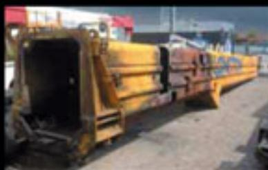
Rusch Kraantechnik bv ist spezialisiert auf die Instandsetzung von Teleskopmasten aller Modelle und Typen von Mobilkränen. Unsere Schweißer sind bis zum Grad 1100 in GGR zertifiziert. Dank unserer Spezialbearbeitung werden selbst Materialermüdungen in den vorherigen Originalzustand aufbereitet. Die Reparatur Ihres beschädigten Krans erfolgt deswegen schneller, günstiger und mit der gleichen Kraft wie zuvor.
