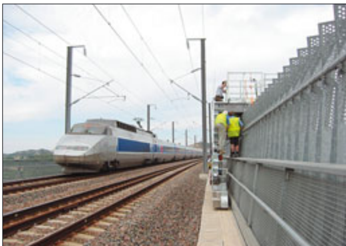
Gerätetyp MBS 90-1,2 im Einsatz bei der französischen Eisenbahn SNCF. Mit dem Brückeninspektionsgerät können bei laufendem Betrieb die Kontrollen und Arbeiten ausgeführt werden.
