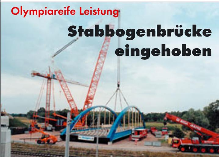
Trotz zeitgleich laufender Olympiaübertragungen wollten viele Zuschauer lieber das Spektakel einer Brückeneinhebung bei Stendal verfolgen. In nur knapp einer Stunde wurde die rund 340 Tonnen schwere Stahlbrücke mit einem Gittermastraupenkrane (Liebherr LRD 1750) aufgenommen, verfahren und über der ICE-Strecke in die Endlage gehoben.
