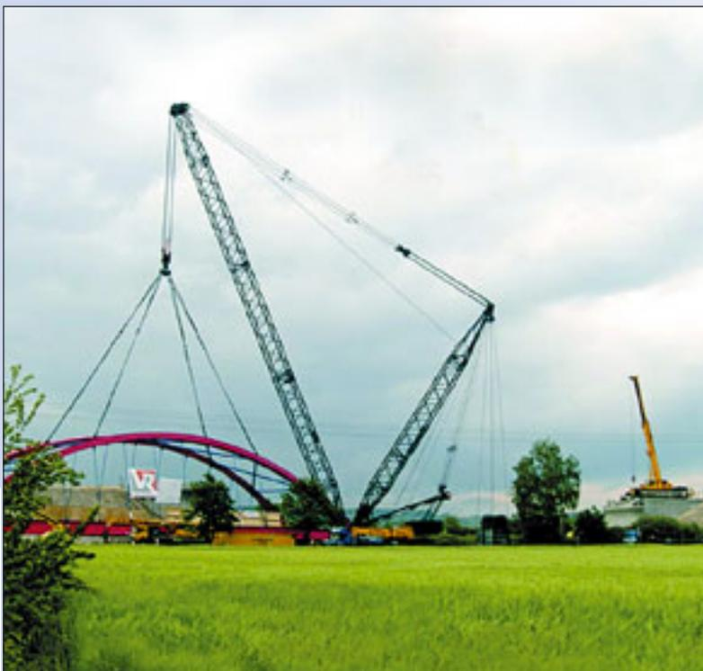
einen 500 Tonnen Terex- Demag Teleskopkran AC 500- 2 ein, der diese Präzisionsaufgabe unter Zeitdruck zügig und professionell erledigte.
