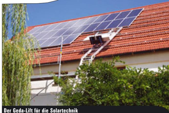
Der Geda-Lift für die Solartechnik
