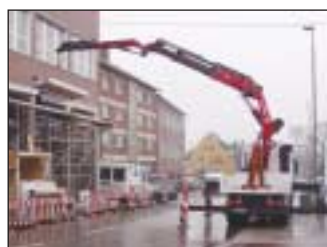
HMF Schwerlastkran Odin mit 52 Metertonnen.
