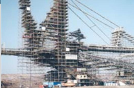
50.000 Kubikmeter Gerüst umspannen den 60 Meter hohen und 250 Meter langen Absetzer im Tagebau Profen
