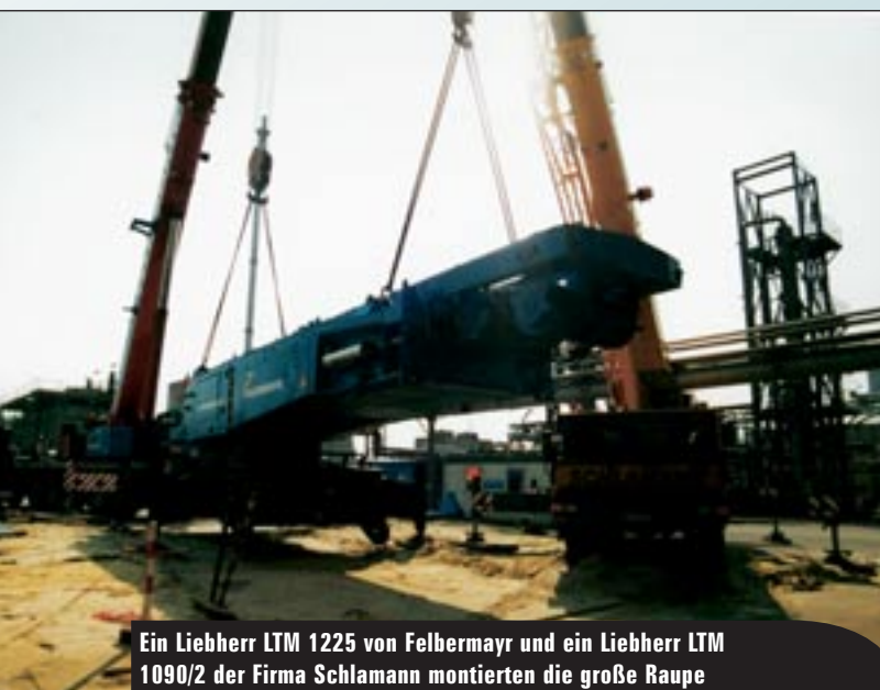
Langsam schwenkt der Kessel am Haken
