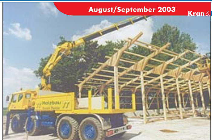
Das Holzbau-Unternehmen Torsten Thümler setzt für die Montage auf einen Tirre Euro 262 mit sechsfachem hydraulischen Ausschub
