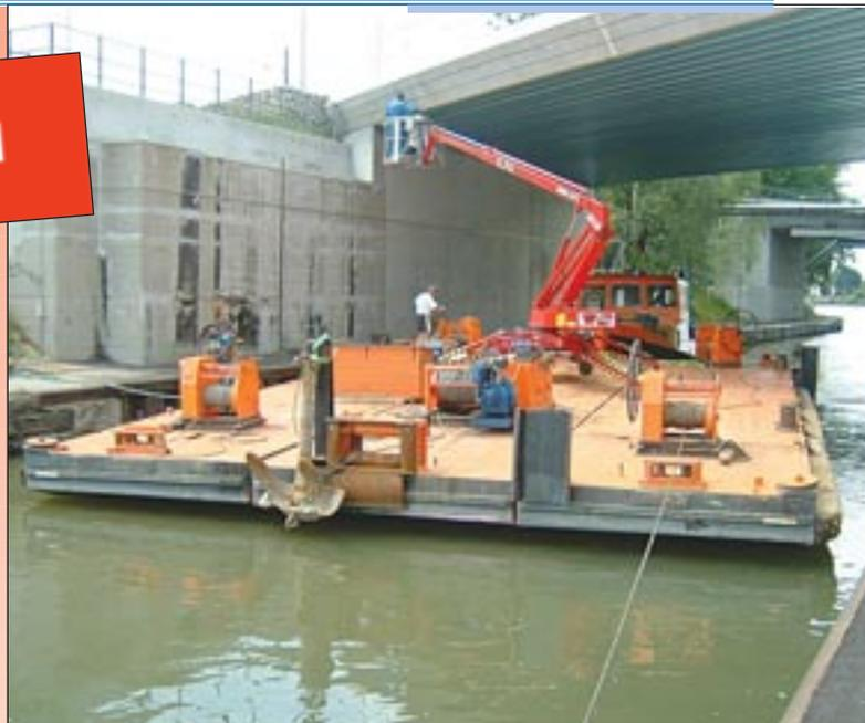
Für Montage- und Malerarbeiten an der Brücke im Hafenbecken 2 von Basel hat das ausführende Bauunternehmen Batigroup auf eine Denklift DL 15 der WS-Skyworker AG gesetzt. Der Zugag war über ein Ponton aus möglich. Die Brücke ist eine der Hauptverbindungen zwischen der deutschen Stadt Weil am Rhein und Basel.
