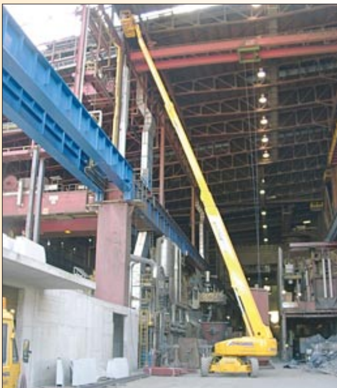
Sechs Teleskopbühnen hat Prangl bei Genie auf der Intermat geordert unter anderem das 39,9-Meter-Gerät S 125. „Wir haben einen steigenden Bedarf für größere Teleskopbühnen und sind von der Qualität der Genie-Maschinen und dem Service sowie der schnelleren Lieferung beeindruckt“, erklärt Christian Prangl.
