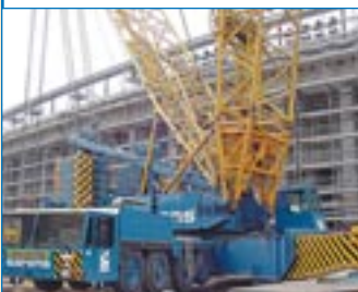
Der TC 3200 SL von Sarens beim Einsatz im Olympia-Stadion Berlin
