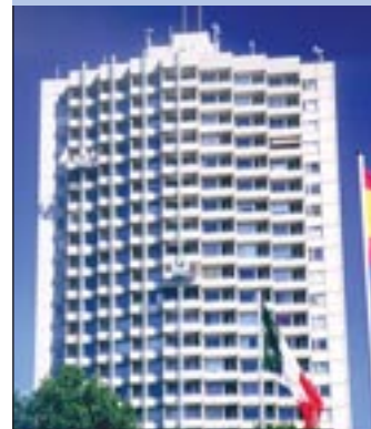
Vier Geda MCP 750 wurden am Aachener Europahaus eingesetzt
