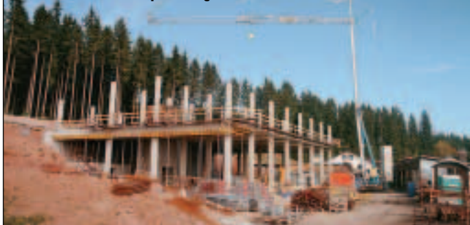
Der K 1035 H von König mit 35 Meter Auslegerlänge und einer Tonne Spitzentragskraft
