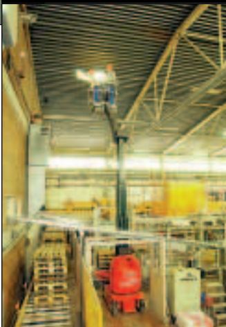
Für interne Wartungsarbeiten setzt das Unternehmen Südzucker eine Manitou 105 VJR ein
