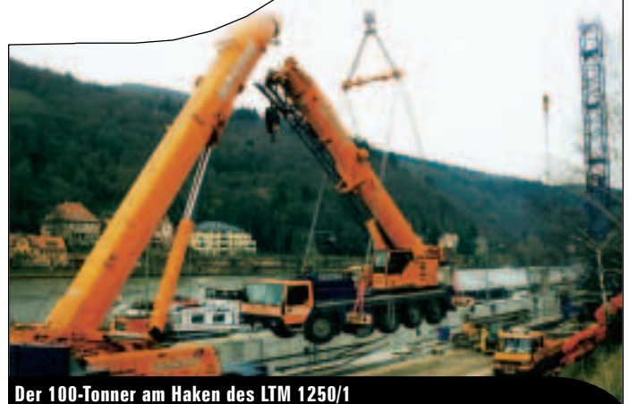
Der 100-Tonner am Haken des LTM 1250/1
