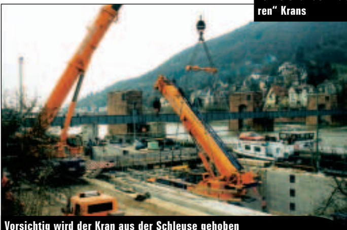
Die Mitarbeiter von Weiland Krane rüsten den Block des 250-Tonnners für den Hub des „kleineren“ Krans
