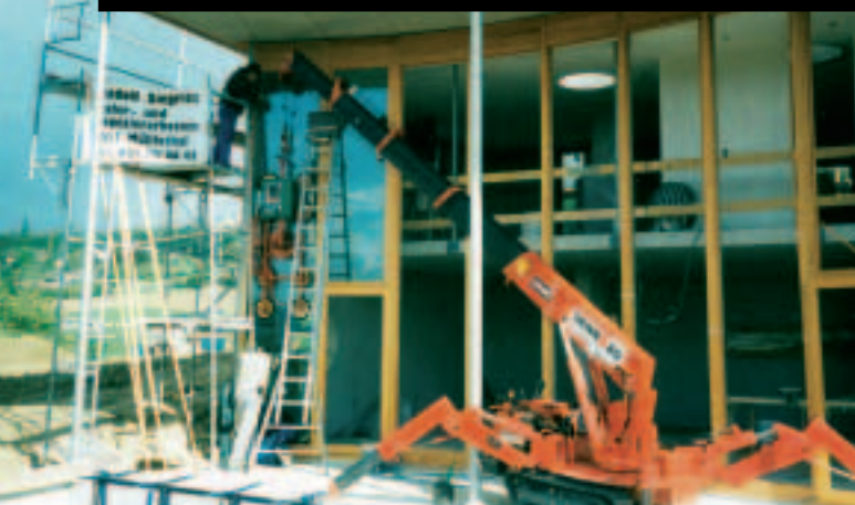
Der Miniraupenkrane von Maeda im Einsatz als Montagehilfe für Glaserarbeiten. Kompaktheit und geringes Eigengewicht ermöglichen einen guten Zugang zum Einsatzort.
