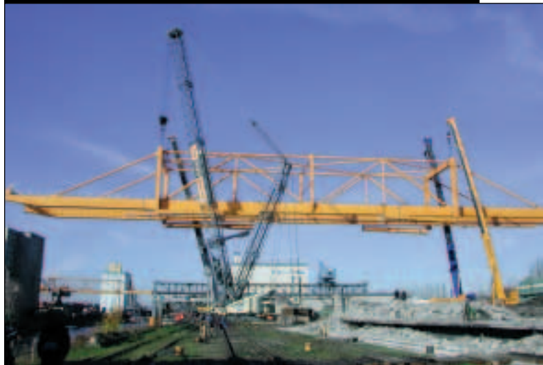
Scholpp setzt verstärkt auf Raupenkrantechnologie. In Köln wurde der Demag CC 2500 des Unternehmens für den Umbau des Müngersdorfer Stadions eingesetzt.
