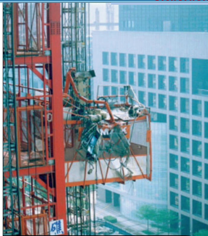
Ein Erdbeben der Stärke 6,8 erschütterte Taipei, die Hauptstadt Taiwans. Herabfallende Stahlteile rissen den Motor einer Alimak-Mastkletterbühne in 40 Meter Höhe ab. Die Sicherheitseinrichtung brachte das Gerät nach 1,5 Meter Sturz zum Halten.
