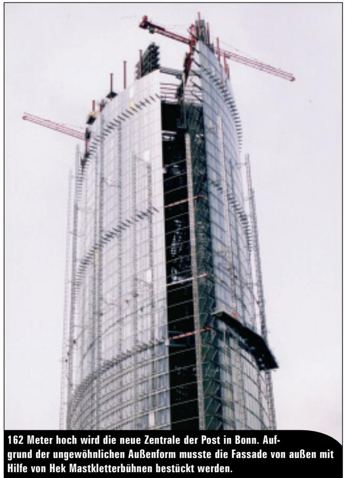
162 Meter hoch wird die neue Zentrale der Post in Bonn. Aufgrund der ungewöhnlichen Außenform musste die Fassade von außen mit Hilfe von Hek Mastkletterbühnen bestückt werden.
