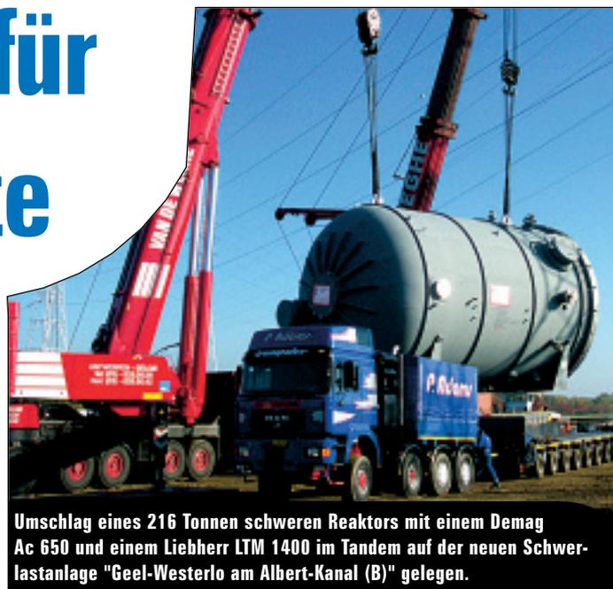
**Umschlag eines 216 Tonnen schweren Reaktors mit einem Demag Ac 650 und einem Liebherr LTM 1400 im Tandem auf der neuen Schwerlastanlage "Geel-Westerlo am Albert-Kanal (B)" gelegen.**
