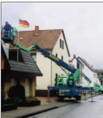
Nach einem Brand in einem Kunststofflager in Bielefeld mussten die umliegenden Wohnhäuser von kontaminiertem Ruß befreit werden. Zur Reinigung der rund 100 Gebäude kamen 10 LKW-Bühnen mit Arbeitshöhen zwischen 17 und 26 Metern sowie fünf Anhängerbühnen der örtlichen Niederlassung von Zoom zum Einsatz. Die Sanierung dauert zwischen vier Wochen und sechs Monaten.
