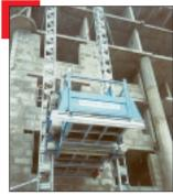
Bereits seinen zweiten Winter in Moskau ist der Zahnstangenaufzug 2000 Z von Geda beim Bau eines 76 Meter hohen Hochhauses im Einsatz. Das Haus wird in der Skelettbeton-Bauweise errichtet, wodurch sehr viel und schweres Material nach oben transportiert werden muss.
