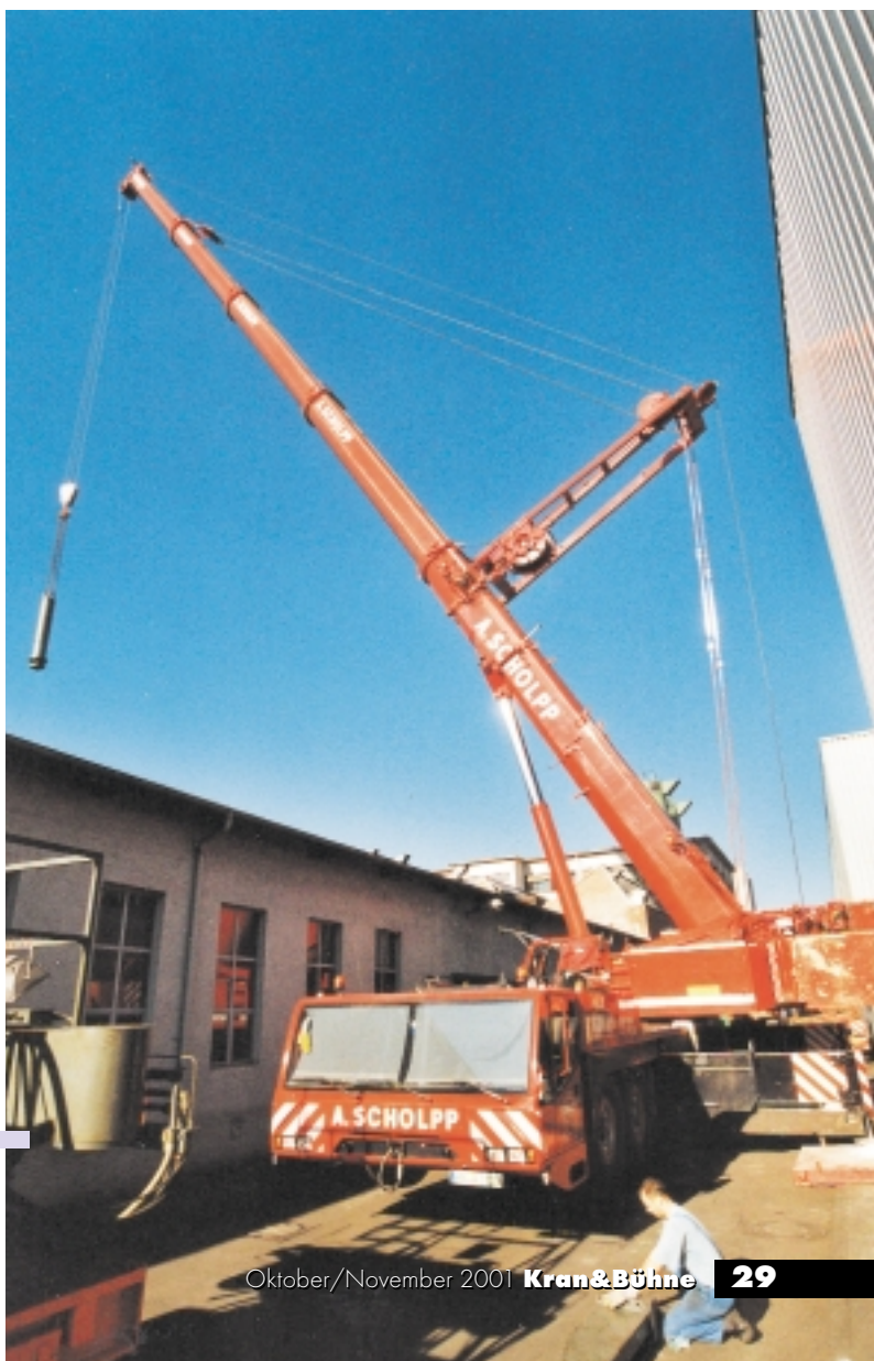
Der Demag AC 300-1 bei Scholpp im Einsatz.
