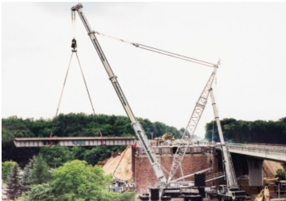
Ein Liebherr LTM 1800 hat in Königs Wusterhausen eine ausgediente Brücke demontiert. Der Kran, der seit einigen Monaten unter der Flagge von Grohmann-Attollo fährt, wird – mit Derrickausrüstung - offiziell von dem Unternehmen als 1000-Tonner geführt. Grohmann-Attollo's nunmehr Größter trug früher die Farben von Ainscough aus Großbritannien. Bevor der Kran nach Berlin kam wurde er generalüberholt und erhielt eine Derrickausrüstung. Derart ausgestattet gibt es weltweit vier LTM 1800.
