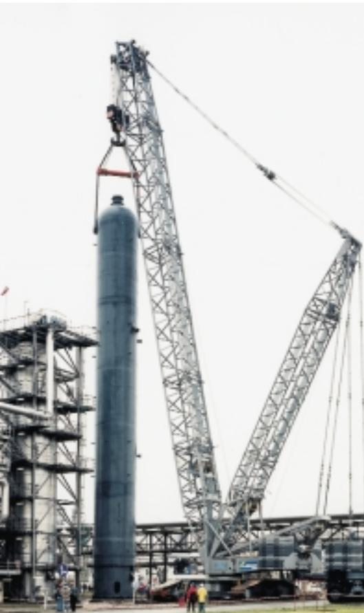
Hauptausleger und 31,5 Meter Derrickausleger wurde der Reaktor bei einer Ausladung von 16 Metern erst einmal in die Senkrechte aufgestellt und dann bei einer Bruttolast von 547 Tonnen aufgenommen.
