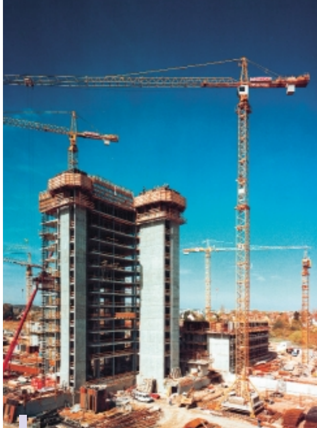
Elf Liebherr-Turmdrehkrane auf Stuttgarts großer Baustelle, dem Stuttgart Engineering Park.
